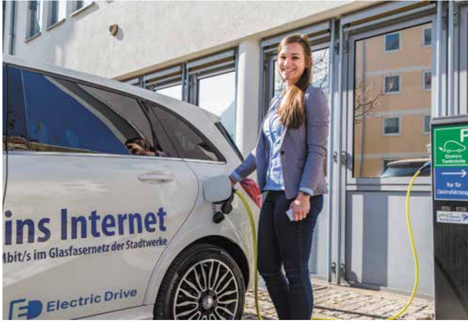
Ladestation für Elektroautos der Stadtwerke Bad Reichenhall
